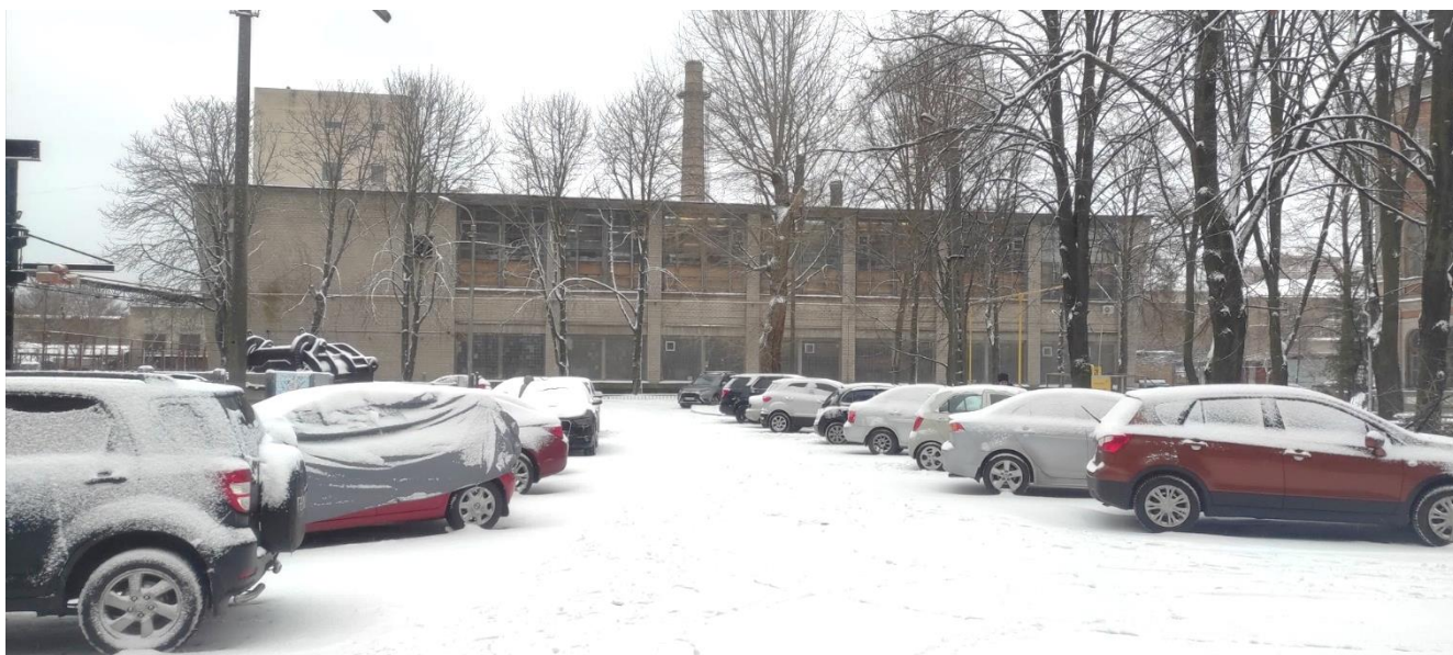
Фото 6 - Під'їзд до будівлі та розташування паркувальних місць
