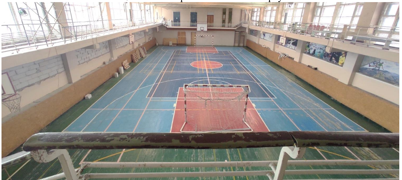
Фото 30 - Спортивна зала 2-го поверху (вид з оглядового майданчика 3-го поверху)
