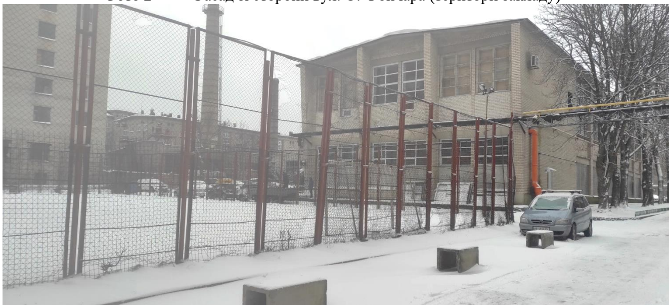
Фото 3 - Фасад зі сторони просп. Д. Яворницького (території закладу)
