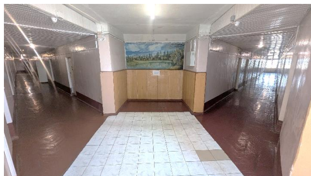
Фото 14 - Характерний вигляд внутрішніх горизонтальних шляхів руху
