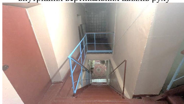
Фото 20 - Характерний вигляд внутрішніх вертикальних шляхів руху (спуск до приміщень душових то пральні)
