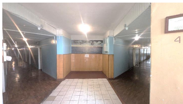
Фото 16 - Характерний вигляд внутрішніх горизонтальних шляхів руху
