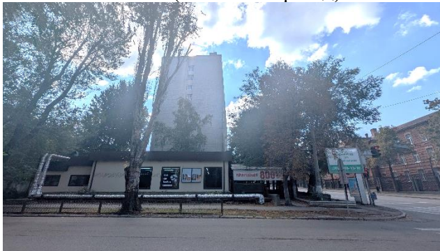
Фото 3 - Загальний вигляд будівлі та прибудинкової території
