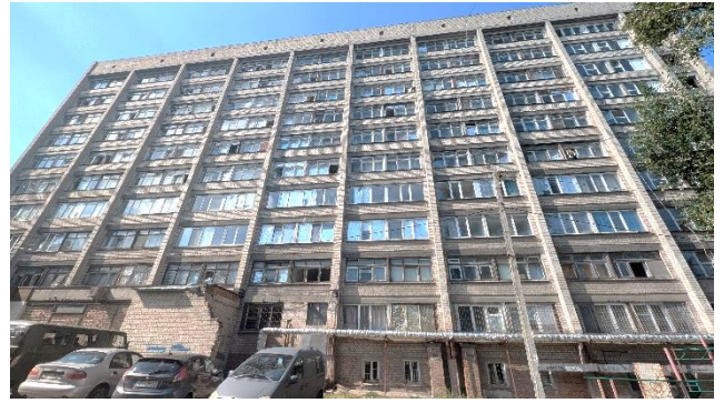
Фото 2 - Загальний вигляд будівлі та прибудинкової території
