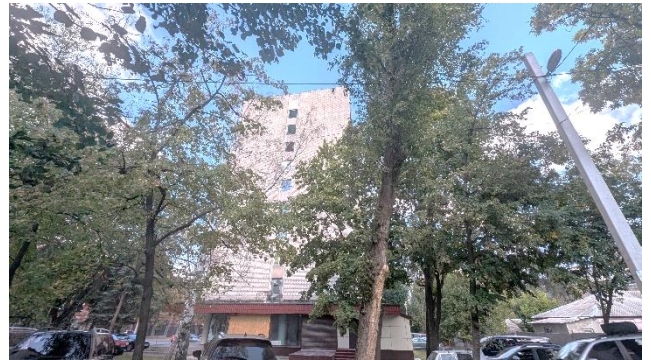
Фото 4 - Загальний вигляд будівлі та прибудинкової території
