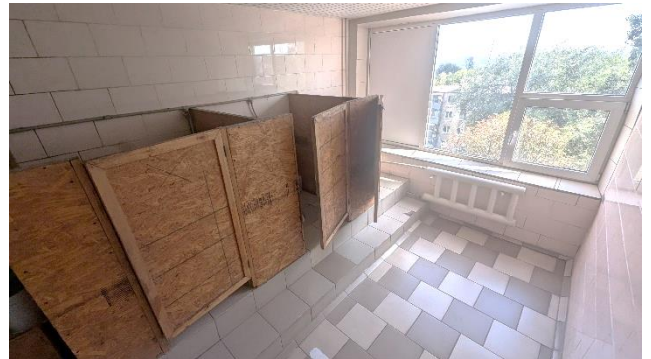
Фото 36 - Характерний вигляд санітарно-гігієнічних приміщень
