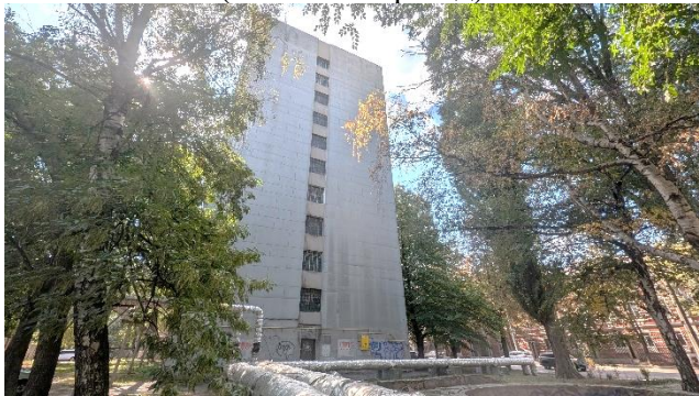
Фото 3 - Загальний вигляд будівлі та прибудинкової території
