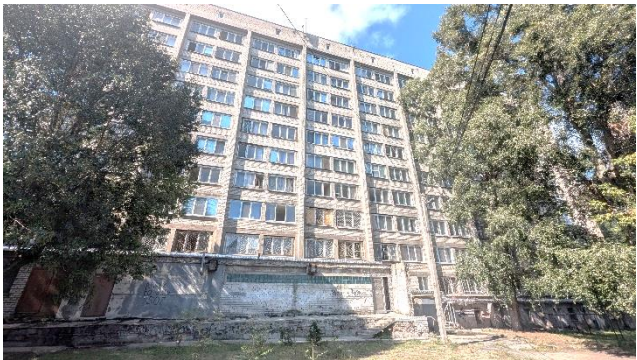
Фото 2 - Загальний вигляд будівлі та прибудинкової території
