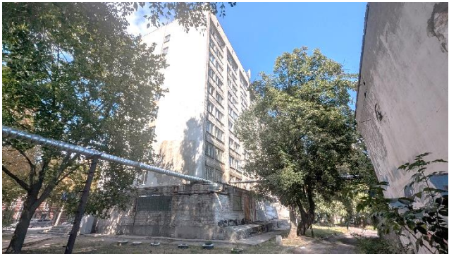
Фото 4 - Загальний вигляд будівлі та прибудинкової території
