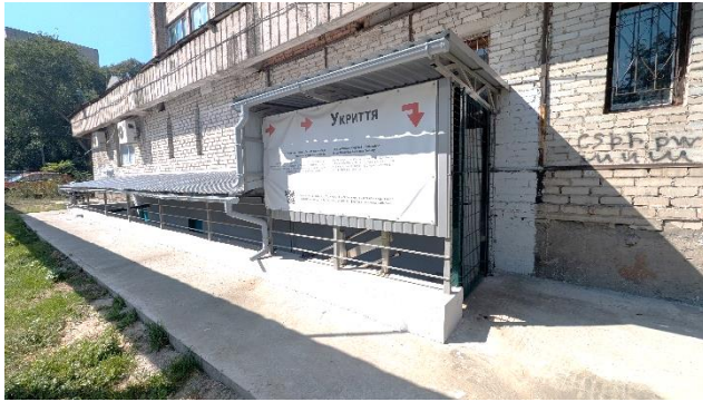
Фото 9 - Вхідна група ззовні будівлі до укриття
