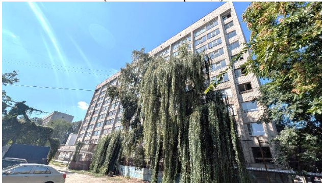
Фото 3 - Загальний вигляд будівлі та прибудинкової території
