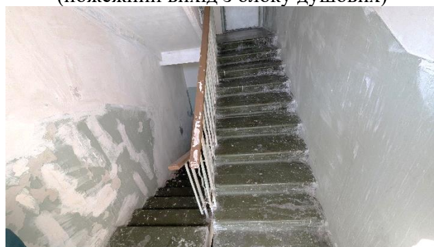
Фото 24 - Характерний вигляд внутрішніх вертикальних шляхів руху (пожежна сходові клітина)
