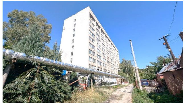
Фото 4 - Загальний вигляд будівлі та прибудинкової території
