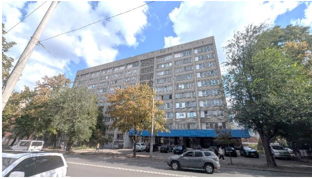
Фото 1 - Загальний вигляд будівлі та прибудинкової території (Головний фасад)
