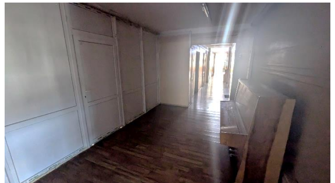
Фото 16 - Характерний вигляд внутрішніх горизонтальних шляхів руху
