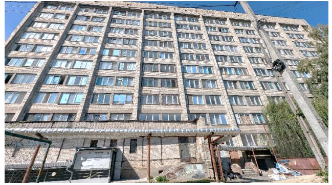
Фото 2 - Загальний вигляд будівлі та прибудинкової території
