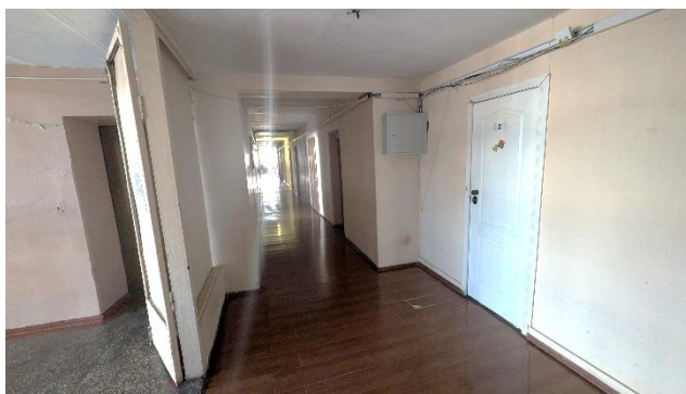
Фото 17 - Характерний вигляд внутрішніх горизонтальних шляхів руху
