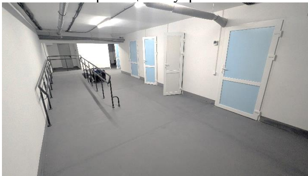
Фото 43 - Характерний вигляд приміщення укриття
