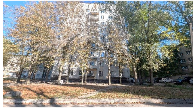
Фото 2 - Загальний вигляд будівлі та прибудинкової території (фасад зі сторони просп. Олександра Поля)
