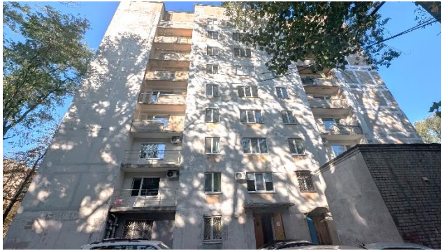
Фото 1 - Загальний вигляд будівлі та прибудинкової території (фасад зі сторони вул. Олександра Шербакова)
