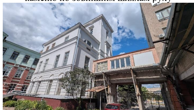
Фото 15 - Надземний перехід до корпусів №4 та №5 на рівні 2-го поверху
