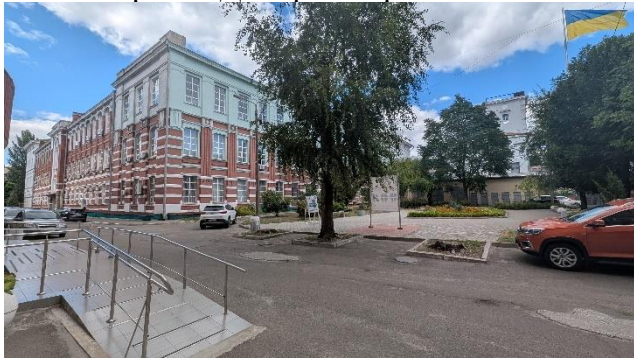
Фото 3 - Фасад будівлі з внутрішнього двору зі сторони просп. Науки
