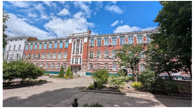
Фото 2 - Фасад будівлі з внутрішнього двору
