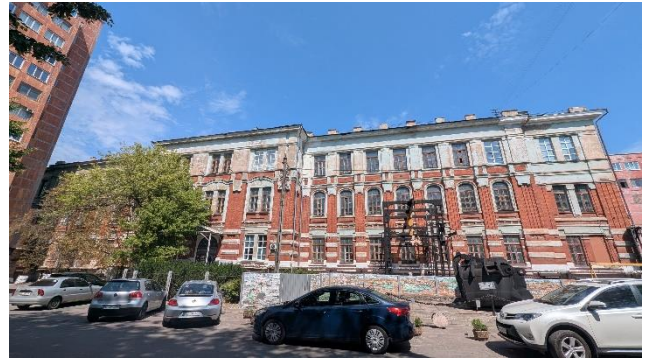
Фото 2 - Фасад будівлі з внутрішнього двору (між корпусами №2 та №3) з парковкою та виходом до укриття
