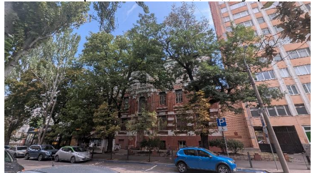
Фото 4 - Фасад будівлі зі сторони вул. О. Гончара з парковкою для МГН
