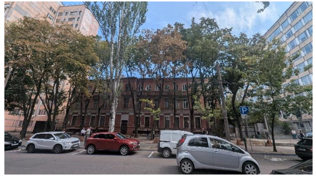
Фото 2 - Фасад будівлі зі сторони вул. О. Гончара з парковкою для МГН
