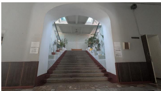
Фото 15 - Центральний хол в місці головного сходового маршу
