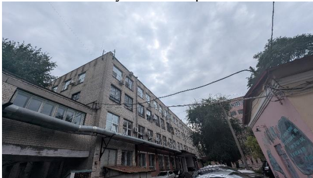
Фото 3 - Фасади будівлі зі сторони просп. Д.Яворницького
