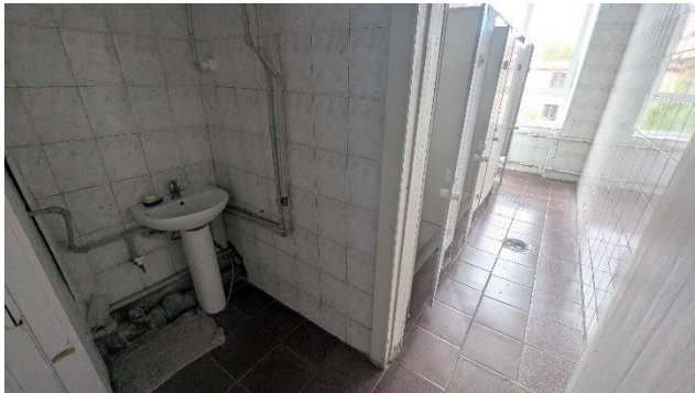
Фото 33 - Характерний вигляд санітарно-гігієнічних приміщень
