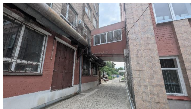
Фото 11 - Надземний перехід до корпусу №10 на рівні 2-го поверху
