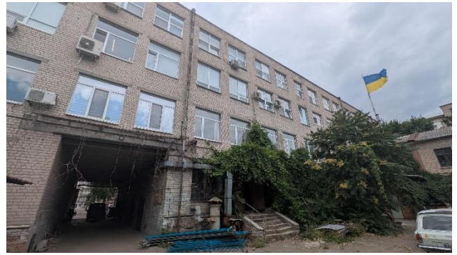
Фото 2 - Фасад будівлі зі сторони просп. Науки
