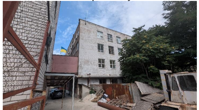
Фото 4 - Фасад будівлі зі сторони вул. Паторжинського
