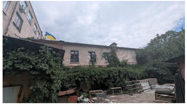
Фото 2 - Фасад будівлі з внутрішнього двору (госп. частина)
