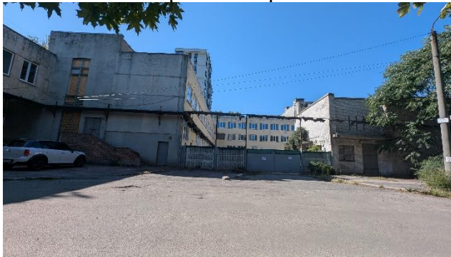
Фото 3 - Фасади будівлі зі сторони в'їзду на плац
