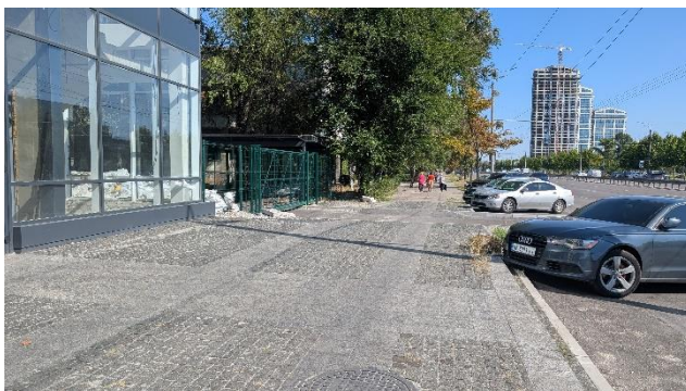
Фото 7 - Зовнішні шляхи руху та паркувальні місця по головному фасаді
