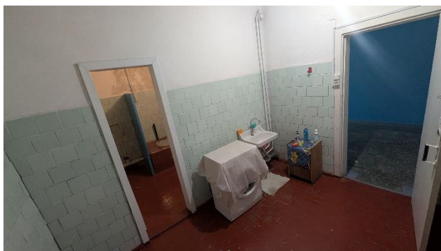
Фото 29 - Характерний вигляд приміщень санітарно-гігієнічних вузлів
