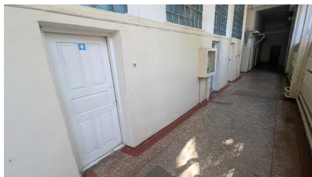
Фото 28 - Характерний вигляд приміщень санітарно-гігієнічних вузлів
