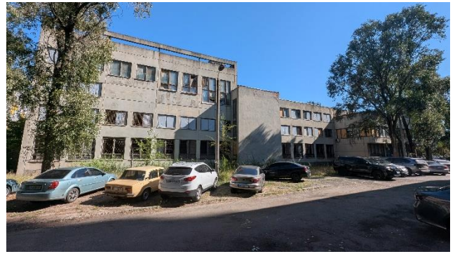
Фото 2 - Фасад будівлі зі сторони вул. Мандриківська
