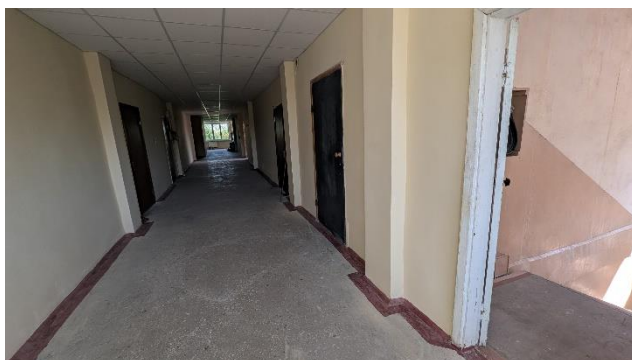
Фото 9 - Характерний вигляд горизонтальних шляхів руху всередині будівлі
