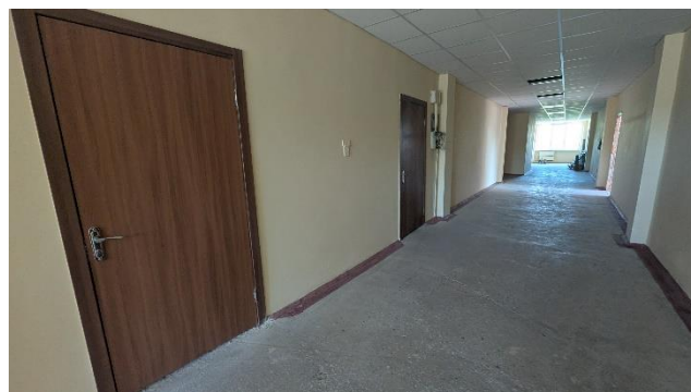
Фото 10 - Характерний вигляд горизонтальних шляхів руху всередині будівлі
