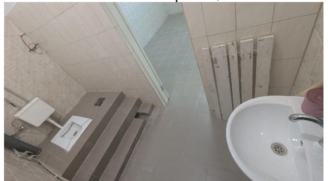
Фото 22 - Характерний вигляд санітарно-гігієнічних приміщень
