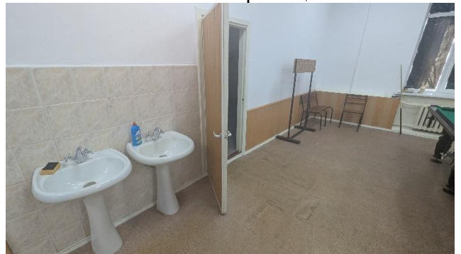
Фото 20 - Характерний вигляд санітарно-гігієнічних приміщень
