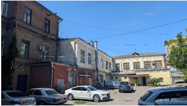
Фото 1 - Загальний вигляд будівлі та прибудинкової території
