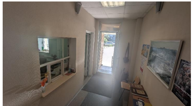
Фото 6 - Вхідна група до господарської частини з приміщенням чергового
