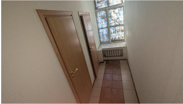
Фото 17 - Характерний вигляд санітарно-гігієнічних приміщень
