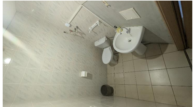
Фото 18 - Характерний вигляд санітарно-гігієнічних приміщень
