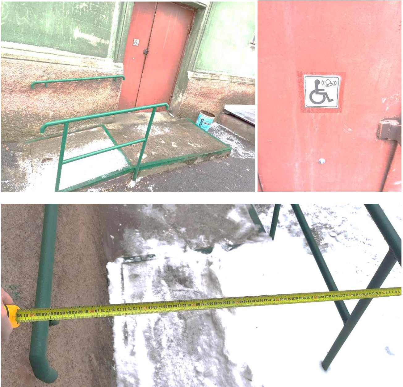
Рис. 2.3. Сталевий пандус входу до будівлі.
