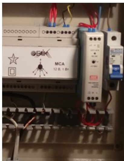
Рисунок 4.4 – Модуль мережевого адаптера у шафі управління моніторингом. Загальний вигляд
