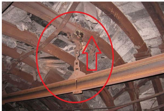
Рисунок 3.3 – Механічні руйнування верхняків аркового кріплення від дії динамічних навантажень ПДМ
